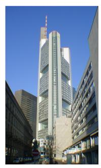
Introdujo sistemas híbridos de climatización, de iluminación, acústicos y para el control de ruidos. Para ello utilizó un patio de luz y ventilación al centro de la planta, con entrepisos transparentes que evitan el efecto chimenea, y una secuencia de terrazas que van girando de manera helicoidal en la vertical del edificio (figuras 4, 5, 12, 13, 8 y 7).
