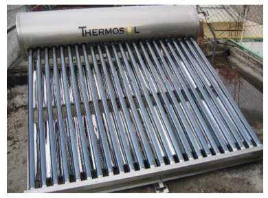
Figura 18. Calentador solar doméstico de agua
